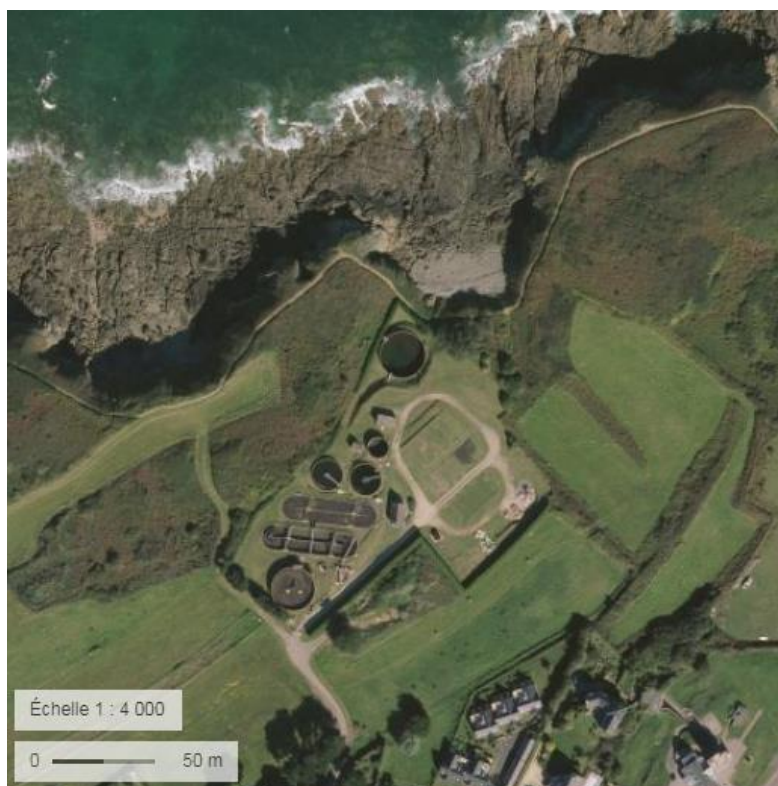
Figure 2 : vue aérienne de la station d'épuration du Sémaphore – Saint Cast le Guildo
